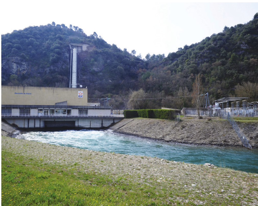
Centrale hydraulique de Vinon-sur-Verdon. A. Van der Stegen
