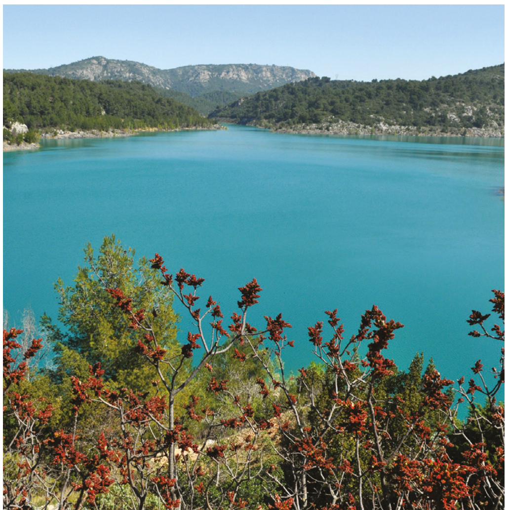
Barrage de Bimont, Vauvenargues. J-P. Garufi
