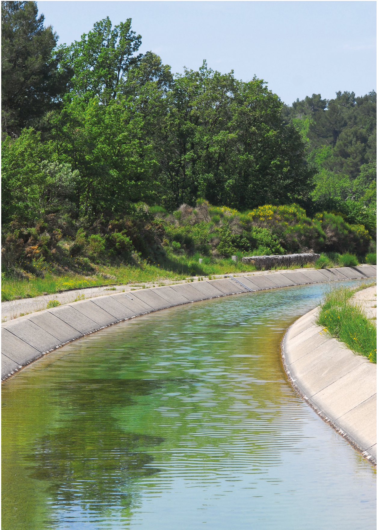
Canal de Provence, A. Van der Stegen
