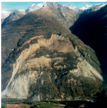
Fig. : La Clapière Déc 1994 – Photo GéoAzur
