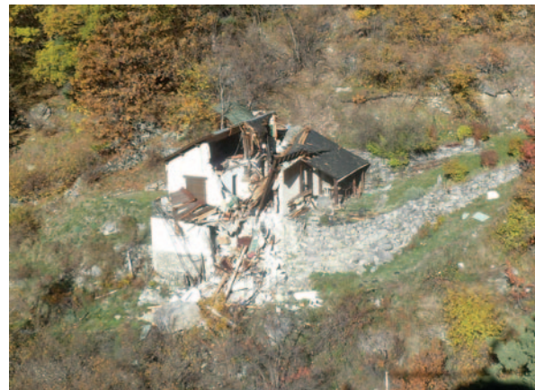
Fig. : blocs Behuédère 2012-11-04 – Photo RTM
