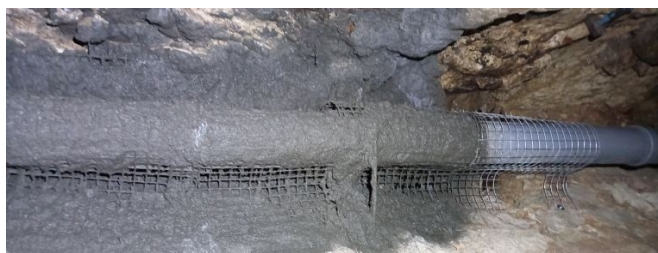
Pose d'un nouveau réseau dans le vallon avec protection armée
