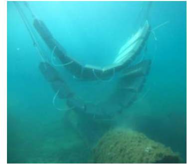
Travaux de réfection des matelas de stabilisation de l'émissaire de la STEP de Vallauris
