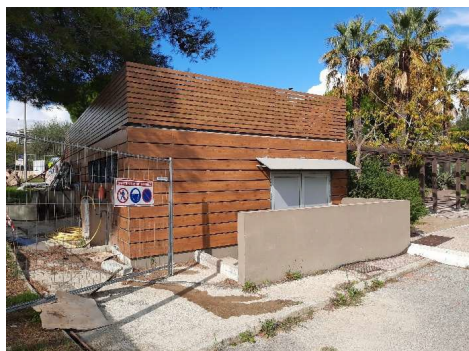
Poste de relevage existant
