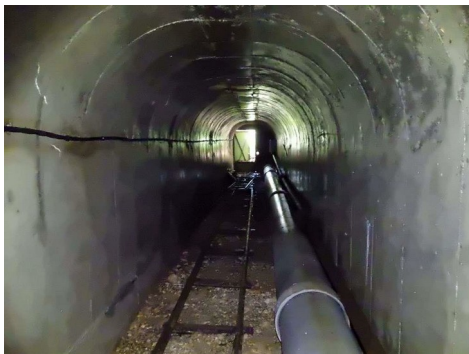
Inspection du tunnel de la conduite de rejet
