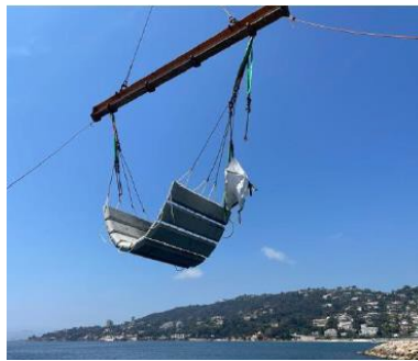
Travaux de réfection des matelas de stabilisation de l'émissaire de la STEP de Vallauris
