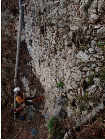
Rue des remparts – BOUYON
