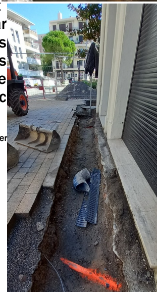
Reprise des branchements existants
