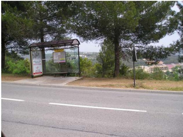
Les arrêts en pleine voie hors agglomération sont de configurations multiples. Il existe des arrêts en pleine voie équipés uniquement d'un poteau (photo 1), sans zone d'attente. D'autres sont équipés d'un véritable aménagement de voirie du type « dégagement de chaussée ». (photo 2).
