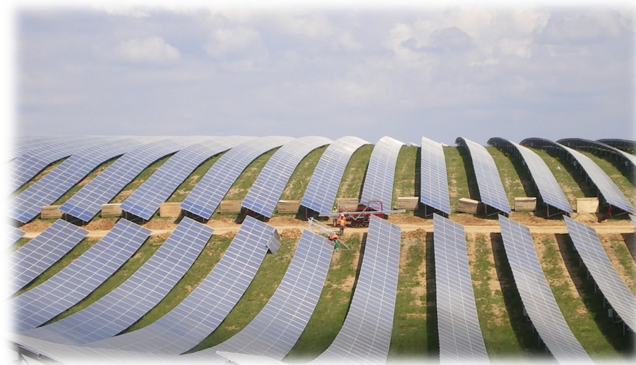
Image 9- Installation de parc solaire au sol – Source : Région – DATTE - STE
