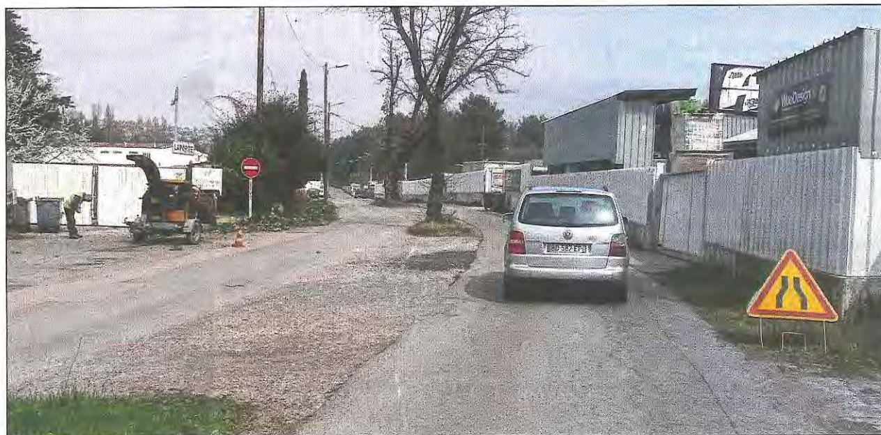
Les riverains demandent des aménagements à court terme comme l'amélioration de la voirie. (Photo J.-M. P.)
